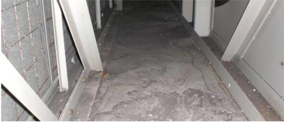
内部に溜まった埃や塵を清掃し、溜まった粉塵のローターへの付着が見られる場合は、エアブローによる清掃作業も行います。清掃されない濃縮装置は風量の低下、性能低下が著しくなります。
